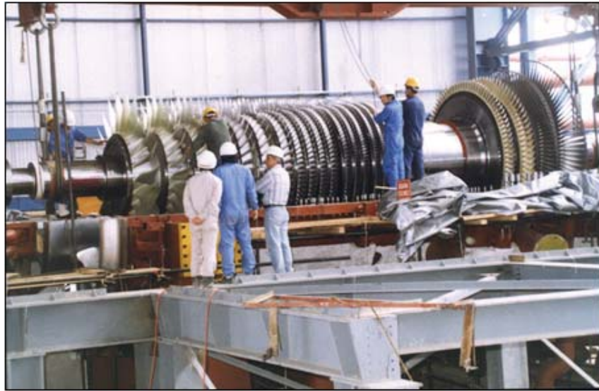
Resim 3.6 Bursa kombine çevrim santralinde gaz türbininin yerleştirilişi
