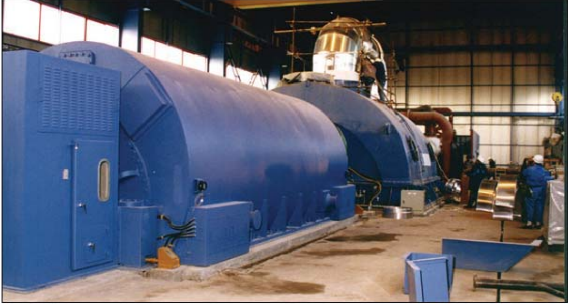
Resim 3.4 Gaz türbinli bir termik santralin gaz türbini ve alternatörünün görünüşü
