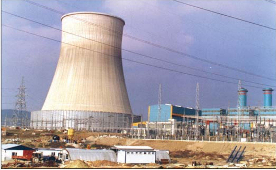
Resim 3.7 Bursa kombine çevrim santralinin 1. ünitesinin görünüşü
