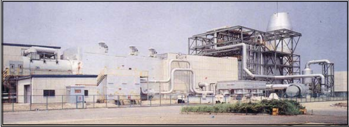
Resim 3.3 701 F tipi gaz türbinli Yokohama santral
